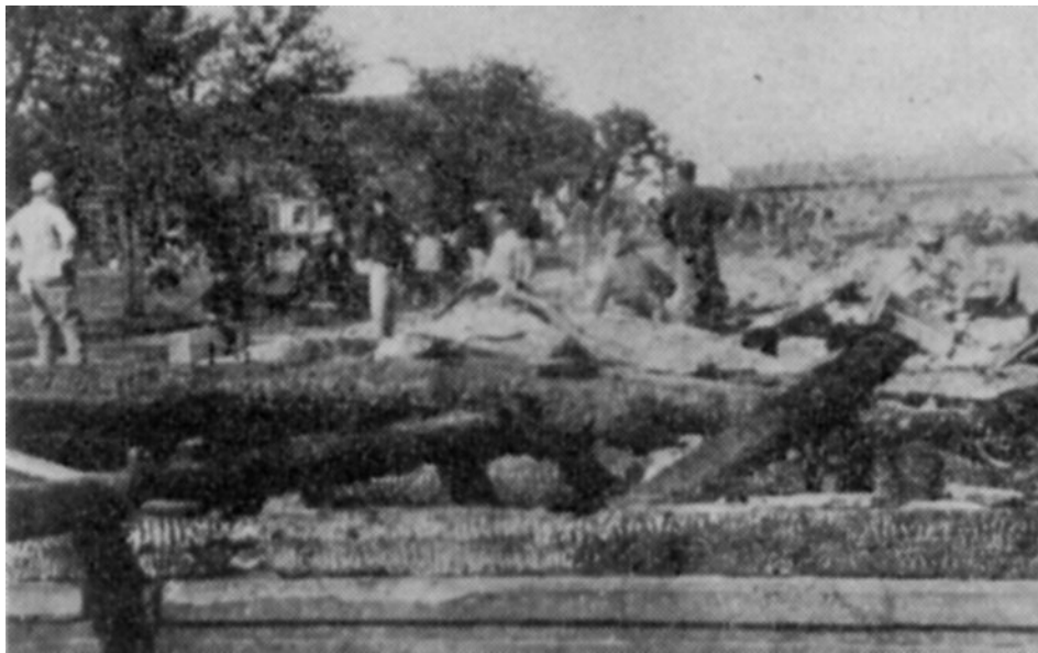
[写真2] 青高校舎となった兵営校舎の焼失跡(焼失は1948年10月25日)
