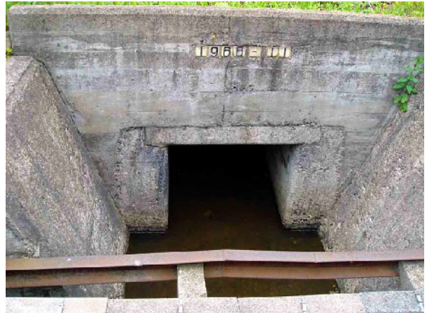
[写真5] かつて操車場下を南側郊外から暗渠で流れてきた水路の開口部が残っている。四角穴の幅は 120 センチ、高さ約 1 メートル。当時を知る人はもっと大きいイメージがあったという。(2007 年 6 月 4 日)
