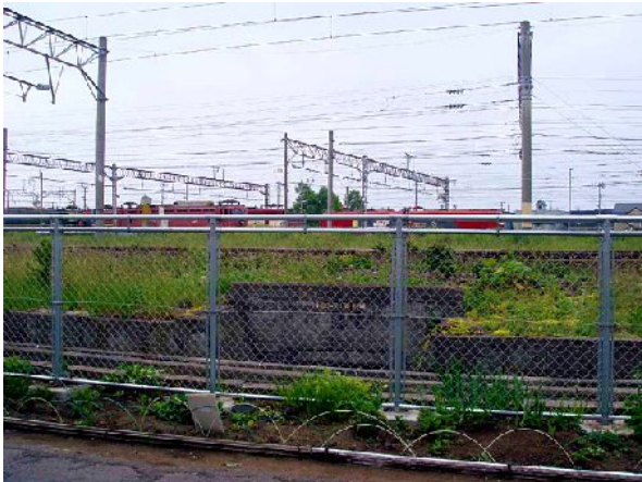
[写真4] 現在の旧操車場付近。手前のフェンス越しに水路開口部が見える。写真5は、その拡大。(2007 年 6 月 4 日)
