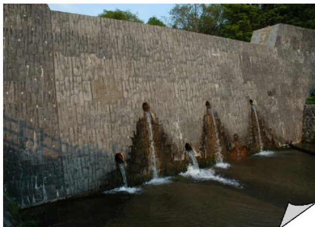
図17 城壁のような砂防ダム:根井川 虫たちの生活環の生命回廊が絶たれる
