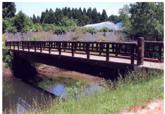
[写真10] 野木和散策橋(2004年6月16日)
