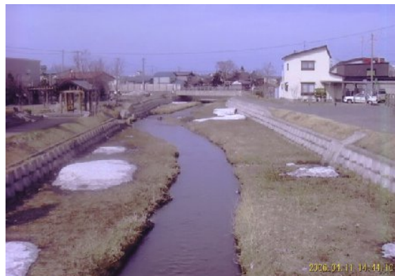
[写真3] 改修工事終了部分(中道橋付近)
