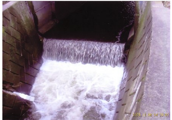
[写真6] 軌道跡下の崩壊箇所(段差が大きい)
