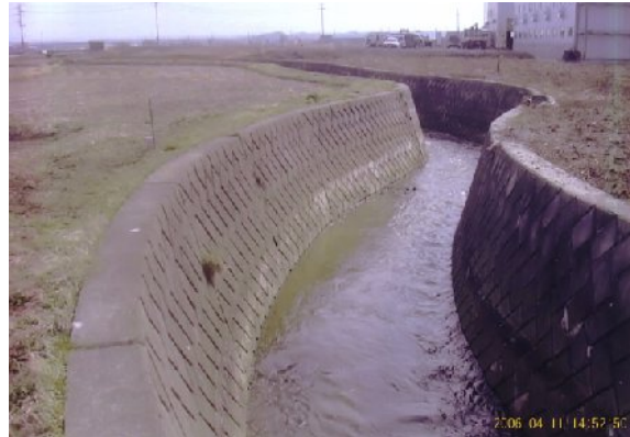
[写真5] 未改修部分
