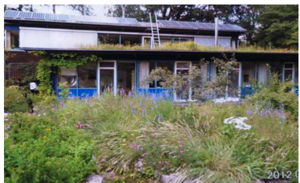
写真48 博士の2階建ての家。2階の屋根も庭になっている
