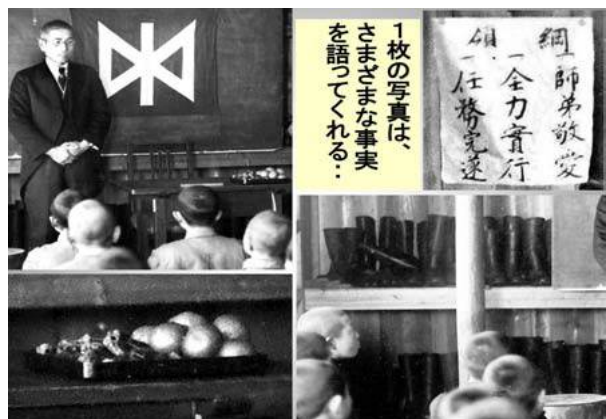
写真13 同上の部分拡大。当時の状況が見える
