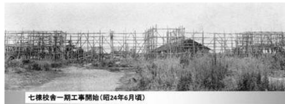
七棟校舎一期工事開始(昭24年6月頃)
