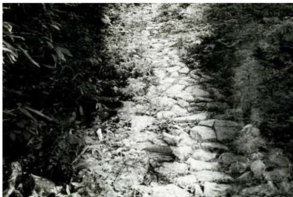
道路の多くは消失, なかには大きな石がむき出しに (1964.7.2, 撮影: 室谷, 以下同じ)
