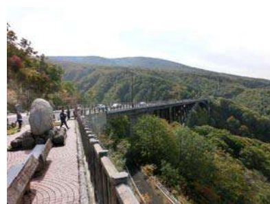
写真29 城ヶ倉大橋(1985年10月27日開通)
